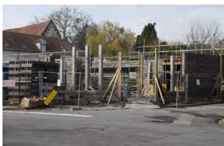
CONSTRUCTION DU RESTAURANT
