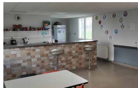
STADE MUNICIPAL RÉNOVATION DU FOYER
