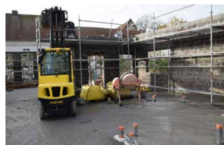
CONSTRUCTION DU RESTAURANT
