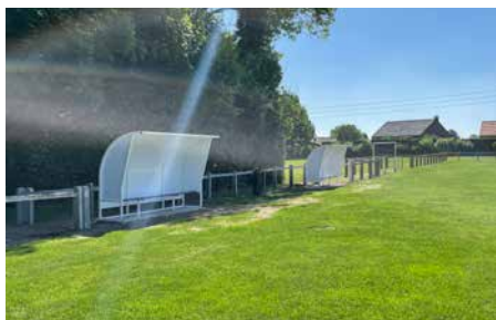
STADE MUNICIPAL POSE D'ABRIS DE TOUCHE
